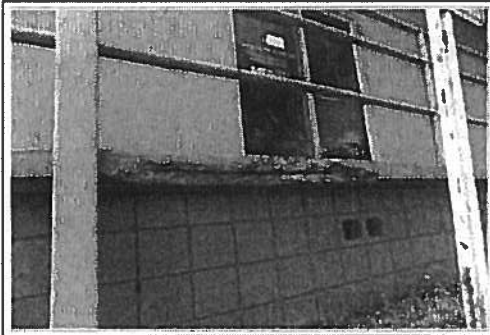
SPALLING
