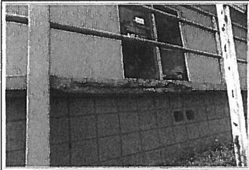
SPALLING
