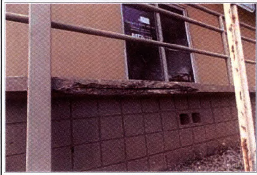
SPALLING
