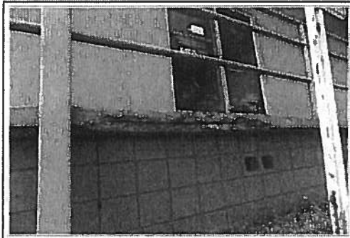
SPALLING
