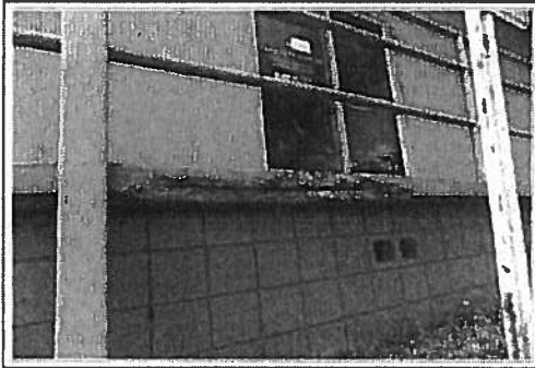
SPALLING
